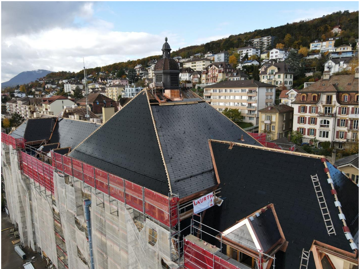
Le Collège des Parcs à Neuchâtel, en rénovation jusqu'en 2025, possède maintenant une toiture active recouverte de milliers de tuiles solaires issues du partenariat entre le CSEM et Freesuns.
