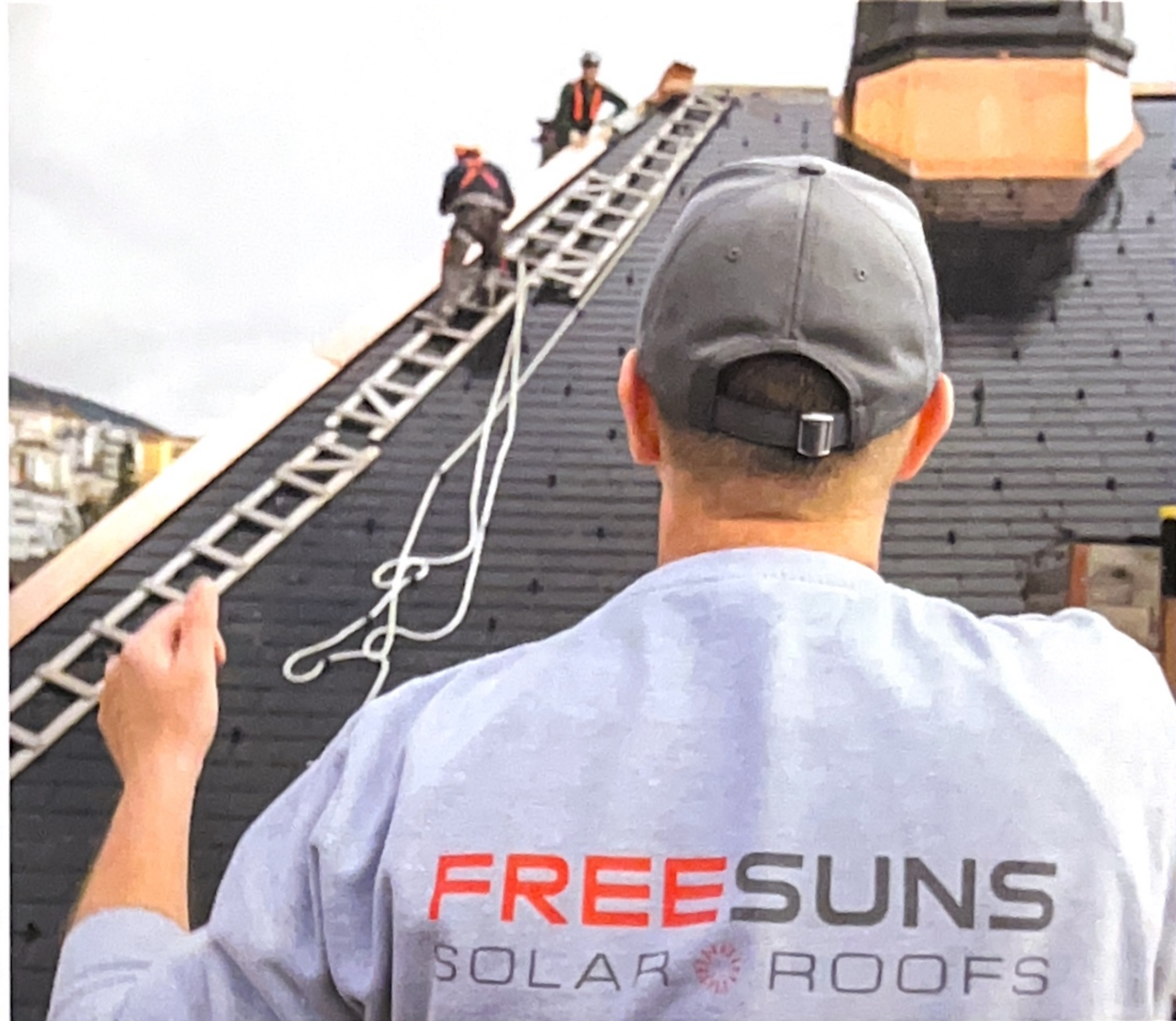
Au total, plus de 17 000 tuiles solaires ont été posées sans nécessiter beaucoup de découpes sur place
