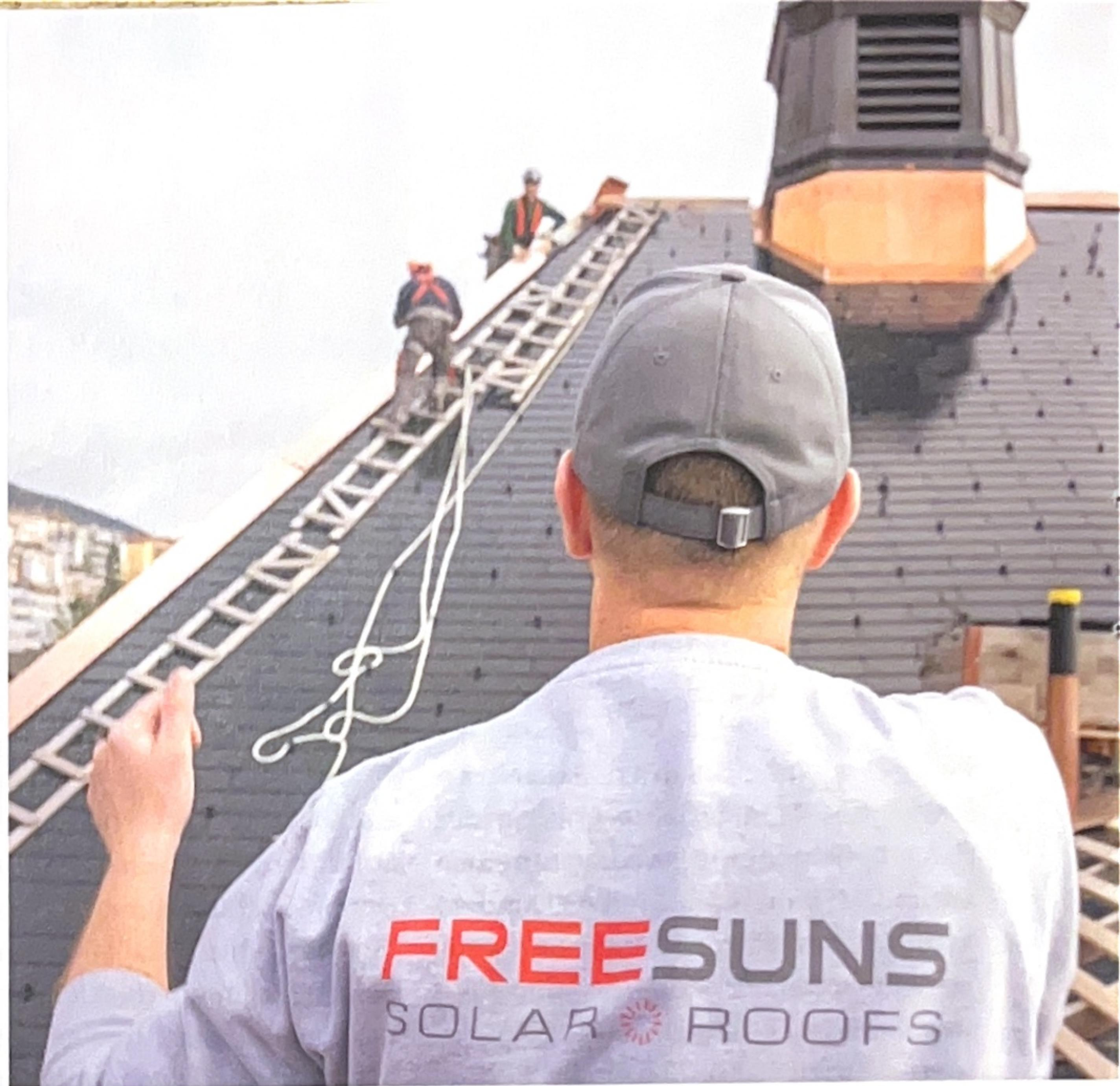
Insgesamt wurden über 17 000 Solarziegel verlegt – alle passgenau für die komplexe Dachform gefertigt, ohne viel Zuschnittarbeiten vor Ort.
